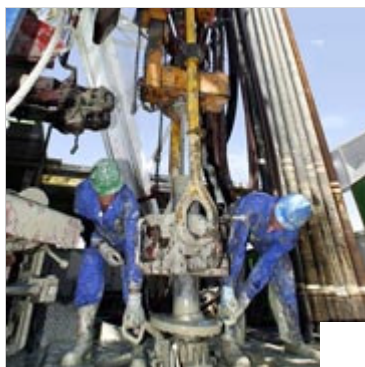
Bohrturm des Unterhachinger Geothermie-Projekts. (Foto: ddp)
