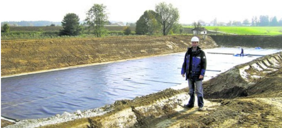
Der Wasserspeicher ist fast so lang wie ein Fußballfeld. Mit auf dem Bild Bauleiter Christian Uschold. Foto: hek
