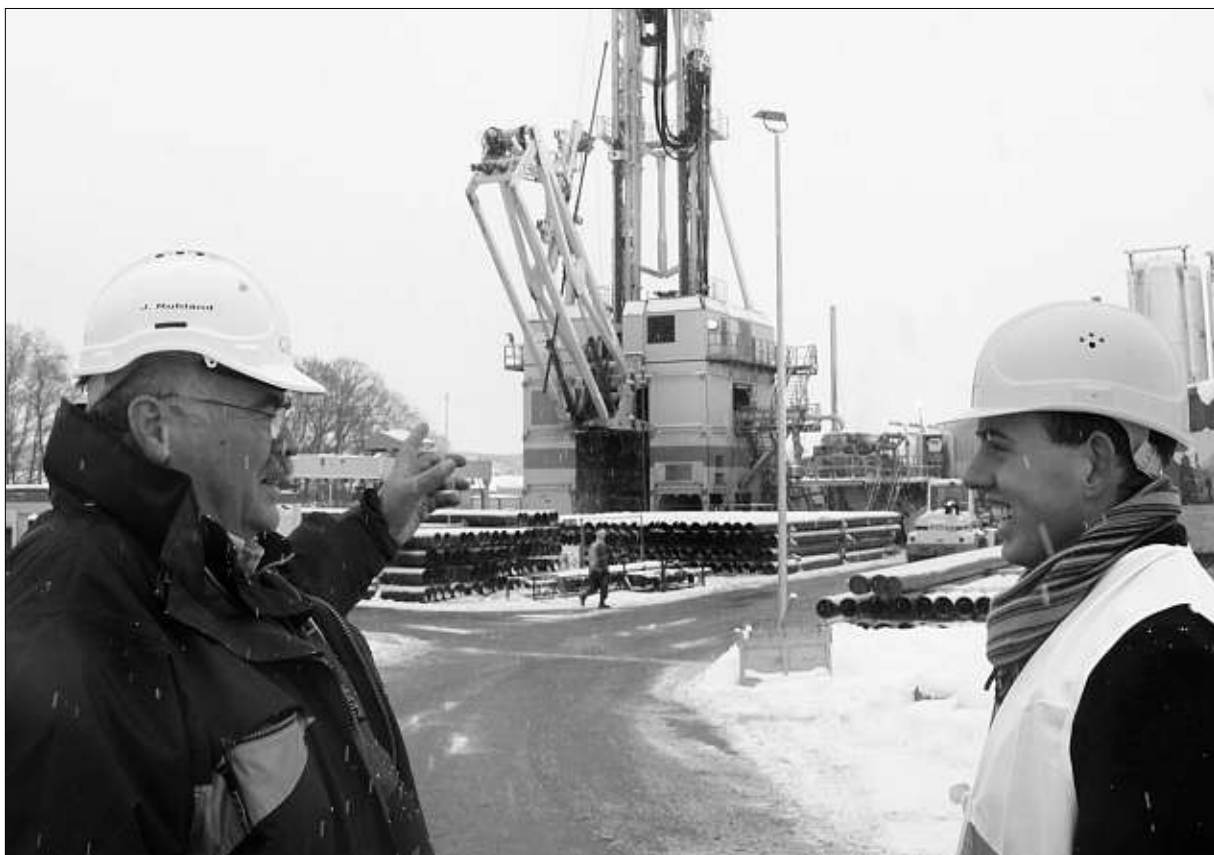
Weihnachtswunsch erfüllt: Johannes Ruhland, Manager der Baustelle, führte Kilian Fleißner über das Geothermiegelände. – Foto: Nöbauer
