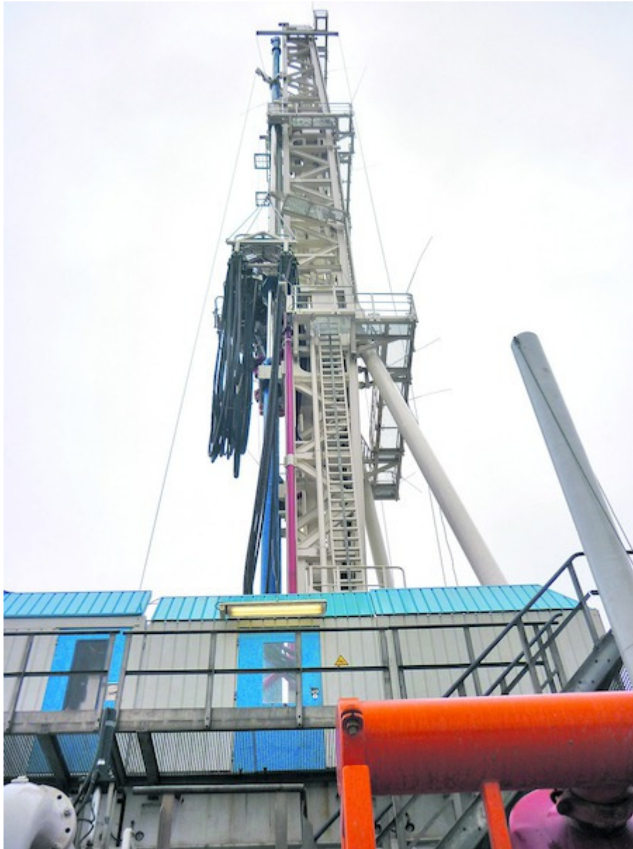
Der Bohrturm in Kirchweidach. Von hier aus hat sich der Bohrer bisher in eine Tiefe von etwa 2300 Metern vorangearbeitet. Foto: wt
