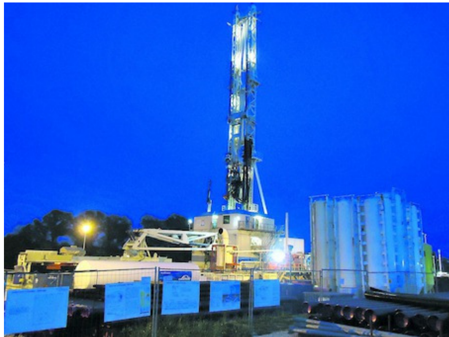
Der hydraulische Bohrturm musste für die zweite Bohrung in Kirchweidach versetzt werden.
