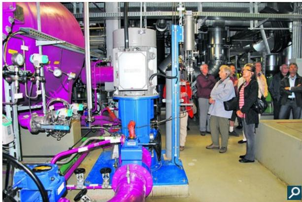
Besichtigung des Geothermie-Werks in Unterhaching: Im großen Tank links befindet sich Ammoniak, das in einem geschlossenen Kreislauf zur Erzeugung von Dampf benötigt wird, der dann wiederum die Turbine für die Stromerzeugung antreibt. Foto: fb
