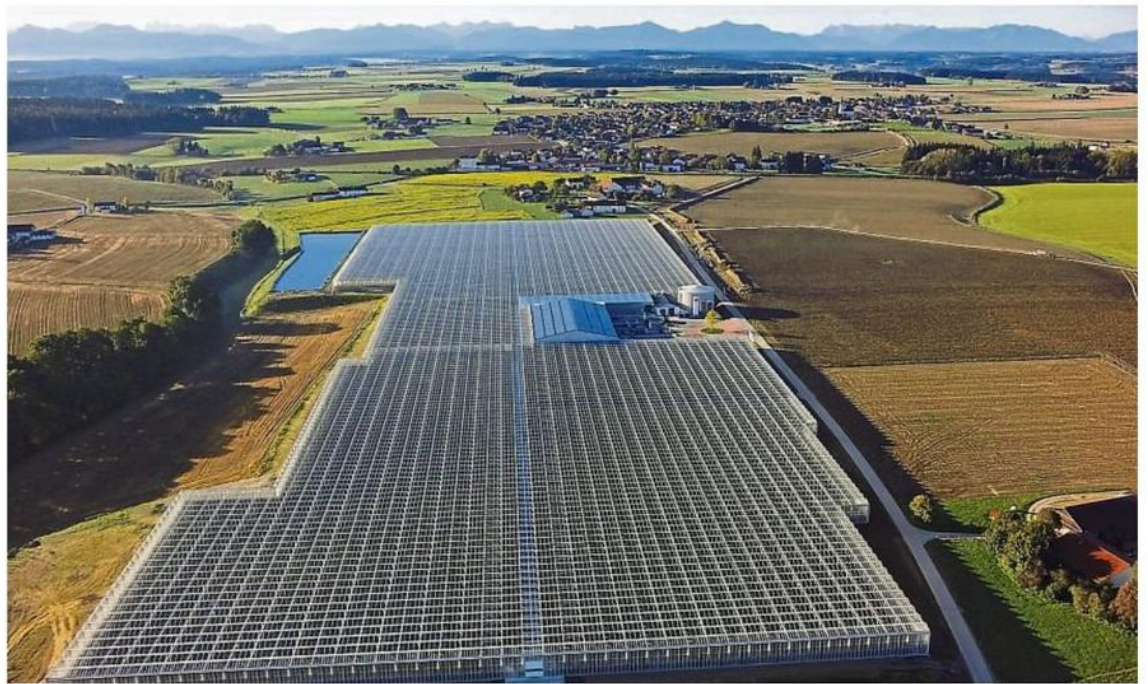
Auf dem Gelände wäre Platz für zweimal die Allianz Arena gewesen. In den riesigen Gewächshäusern reifen nun Tomaten und Paprika.
